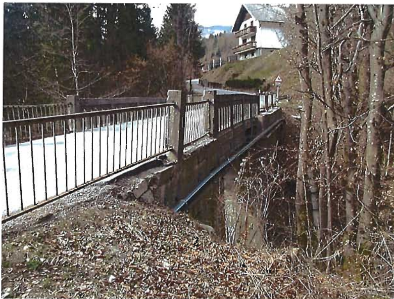
Slika 2: Obstoječi TK vod in vodovod na mostni konstrukciji na gorvodni strani.
