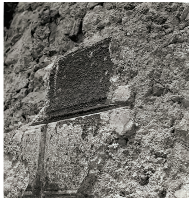
Arhivski posnetek ostanka v rustiki obdelanega pritličja fasade - detajl ometa.
