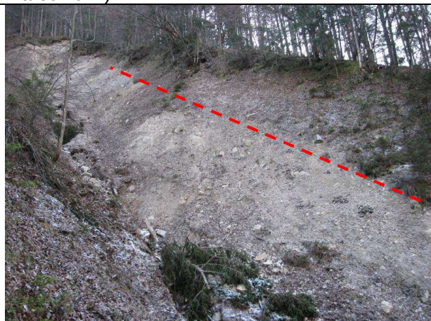
Slika 4: Pogled na manj erodiran del leve brežine med P3 in P5, zgornji del je ustaljen in poraščen z mladjem in stabilnim odraslim drevjem (foto R. Galič, november 2011)
