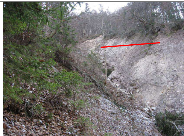
Slika 3: Pogled na spodkopan odlomni rob leve brežine med P5 in P9 (označeno), drevje je nestabilno ter delno nagnjeno in v nevarnosti zdrsa v grapo (foto R. Galič, november 2011)
