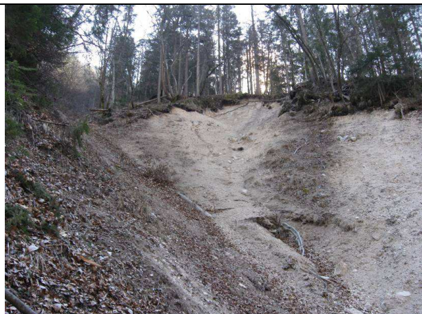
Slika 2: Pogled na ekstremno erozijo v območju P9, strm odlomni rob brežine je labilen in izpostavljen nadaljnjemu erodiranju (foto R. Galič, marec 2012)
