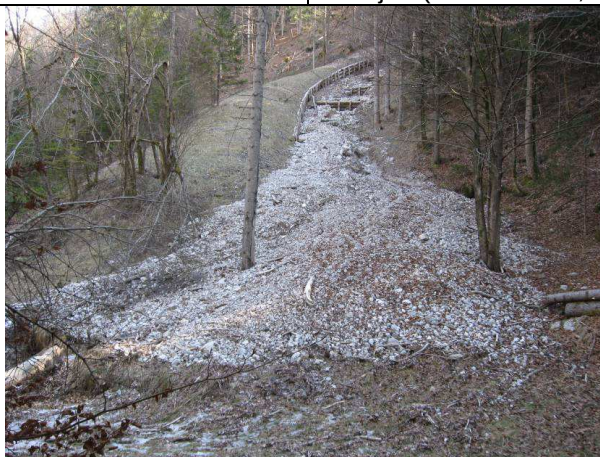
Slika 7: Pogled na iztočni regulirani del grape, med neurjem avgusta 2011 se je sproščeni erozijski material iz erozijskega žarišča odložil v izteku grape in ga zasul (foto R. Galič, marec 2012)
