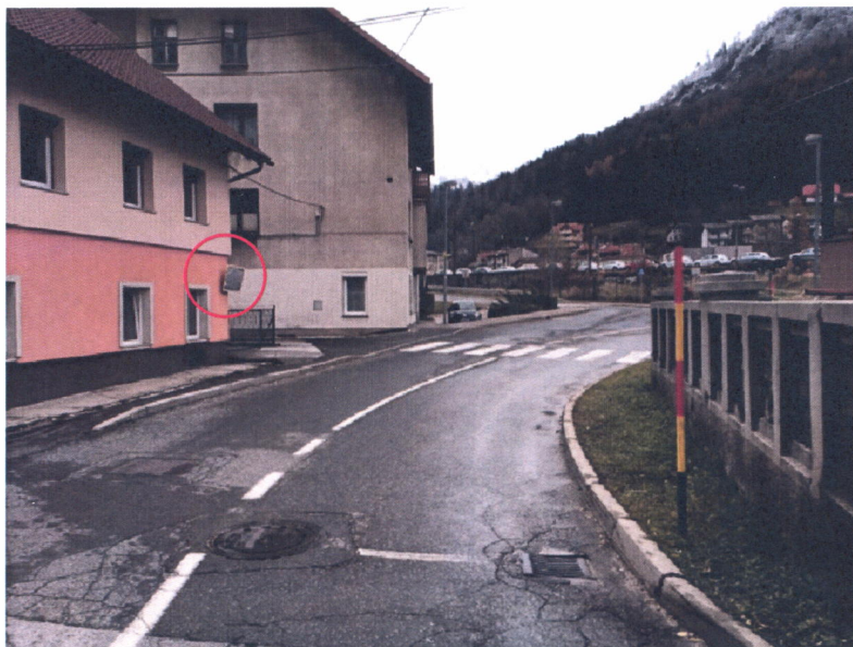
Slika 1 (postavitev cestnega ogledala)
