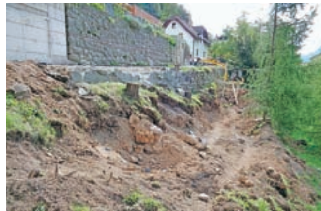
Murova bo dobila kanalizacijo.
