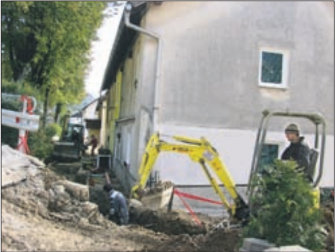
Sedaj potekajo glavna dela pri napeljavi kanalizacijskega omrežja.
