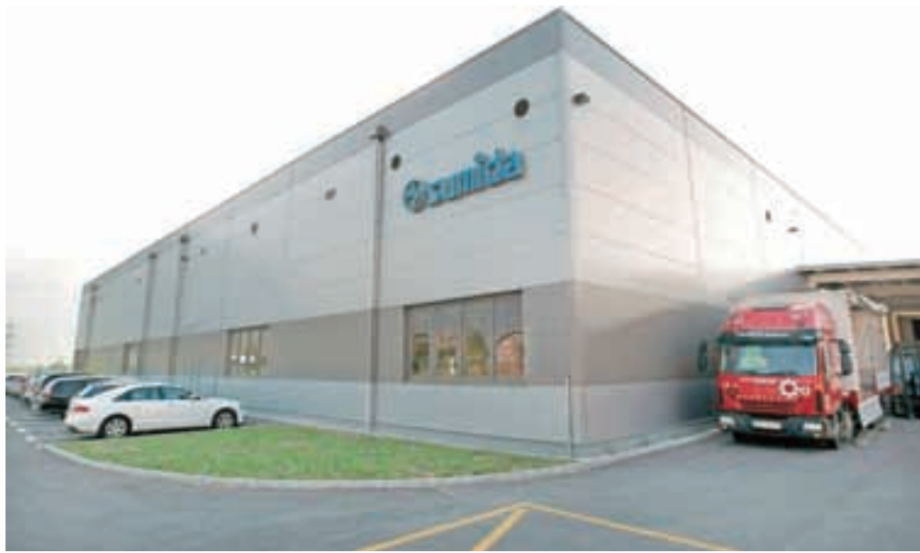
Novi proizvodno-skladišni objekt na Blejski Dobravi / FOTO: GORAZD KAVČIČ
