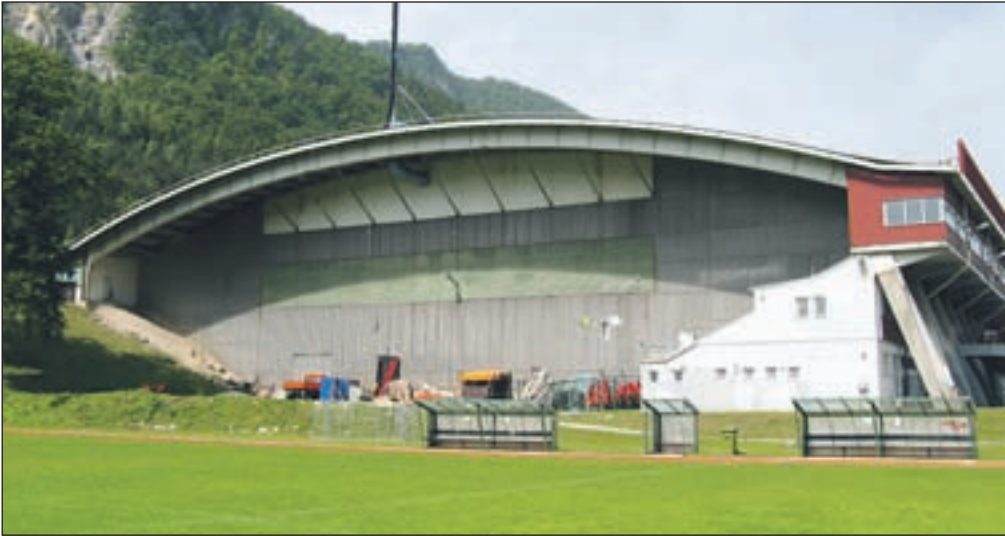
Vzhodni del športne hale Podmežakla, kjer bodo pričeli obnovo. | FOTO: ARHIV OBČINE JESENICE
