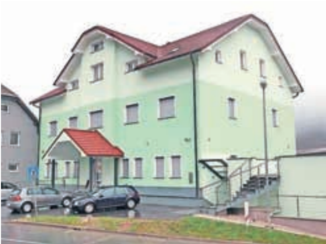
Stavba na Skladiščni ulici, v kateri bo tudi restavracija.
