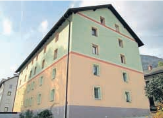
Stanovalci po prenovi prihranijo kar 45 odstotkov pri stroških ogrevanja.
