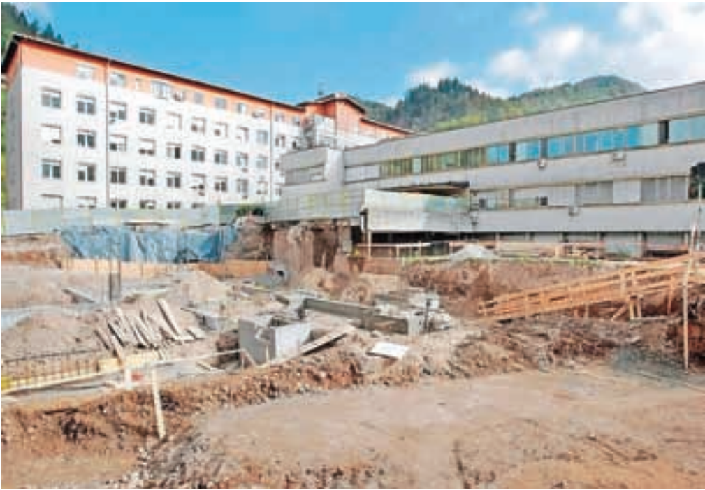
Gradbišče ob bolnišnici / FOTO: GORAZD KAVČIČ
