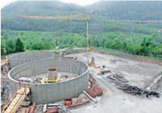
Nadgradnja Centralne čistilne naprave je velik in zahteven projekt. / FOTO: GORAZD KAVČIČ
