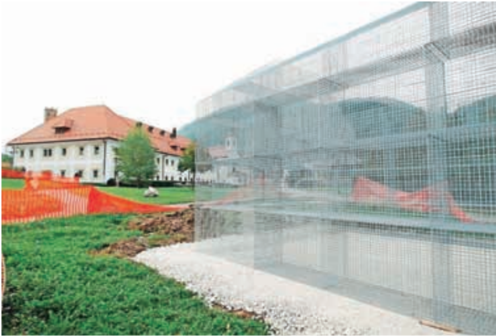
Na mestu nekdanje Korenove hiše že stoji lahka žična konstrukcija iz nerjavečih kovinskih mrež. Obodne zidove naj bi prerasle vzpenjavke, tako da bi nastala "zelena hiška".
