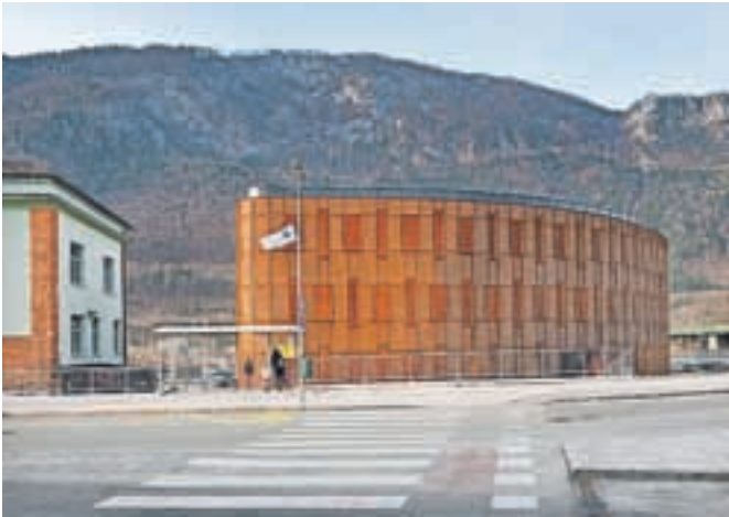
Upravni center Jesenice je primer dobre arhitekture.
