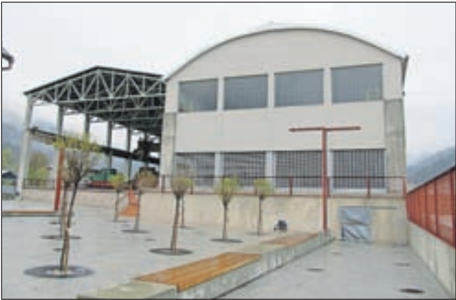
Pokrito tržnico je občina uredila v nekdanji železarski hali.
