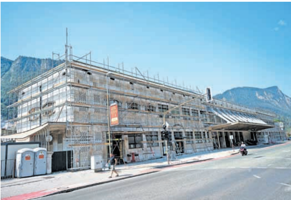
Železniška postaja Jesenice med obnovo / FOTO: NIK BERTONCEJ
