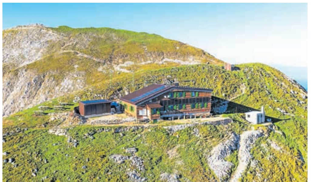
Prešernova koča na Stolu je na čudoviti, a zelo izpostavljeni legi. Z novimi sončnimi paneli izkoristijo vsak sončni žarek za polnjenje baterij. / FOTO: FOTO KOLMAN
