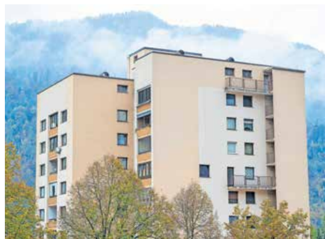
V stolpnici so pred dnevi zaključili obnovo strehe.
