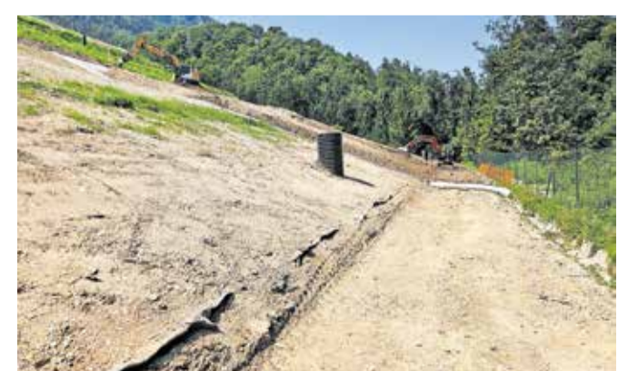
Na deponiji Mala Mežakla gradijo tretje odlagalno polje, na katerem bo dovolj prostora za nenevarne odpadke še za nadaljnjih 25 let. / FOTO: ARHIV OBČINE JESENICE
