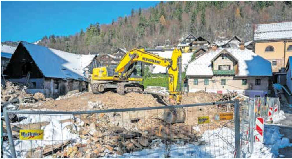
Rušitvena dela so skoraj pri koncu. / FOTO: NIK BERTONCELI
