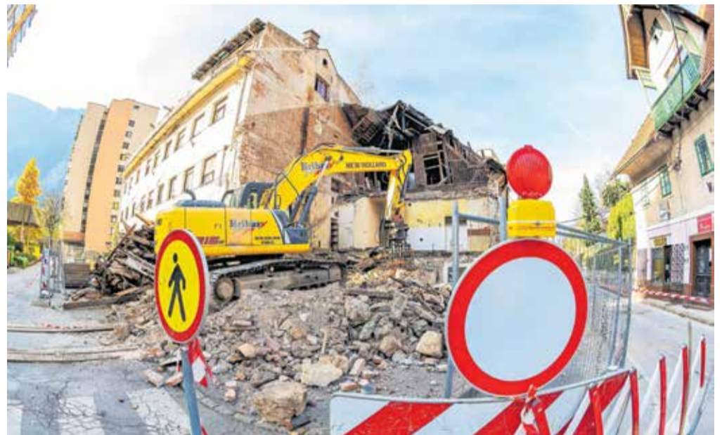
Rušenje hotela Pošta se je začelo ... / FOTO: NIK BERTONCELI
