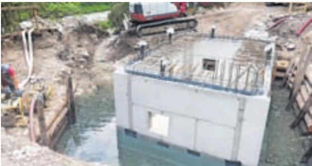
Izgradnja regulacijskega jaška
