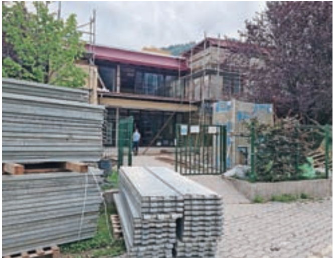
Največja investicija ta čas je energetska sanacija enote Vrtca Angelce Ocepek na Plavžu.
