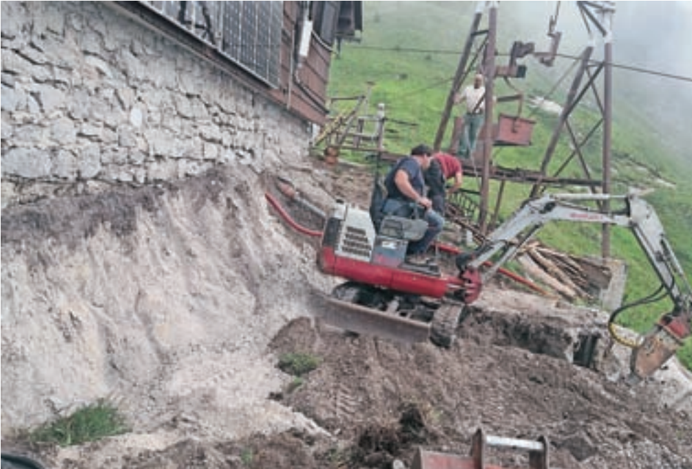
Obsežna gradbena dela pri urejanju čistilne naprave pri Koči na Golici. / FOTO: VLADO HLEDE
