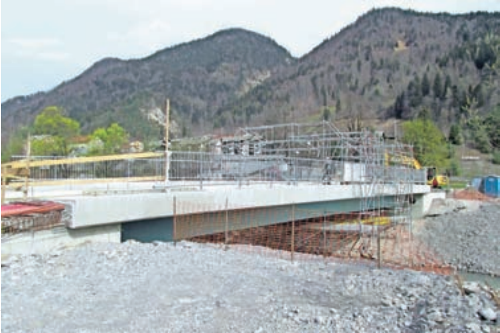
V sklopu projekta izgradnje druge cevi gradijo tudi nov most čez Savo pri Hrušici.
