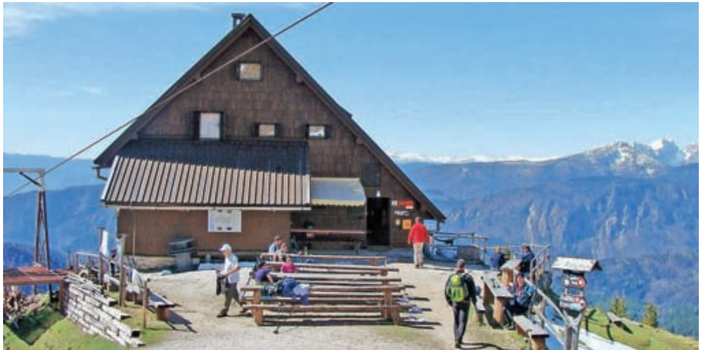
Ko bodo dopuščale razmere, bodo glavno pozornost namenili obnovi Koče na Golici. Namestili bodo nove zunanje sanitarije ter posodobili odvajanje odpadnih voda iz koč.
