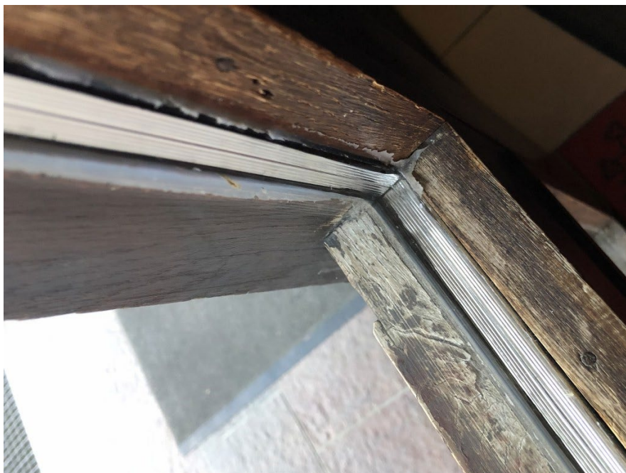
Slika 40: Detajl okna v notranjosti stavbe
