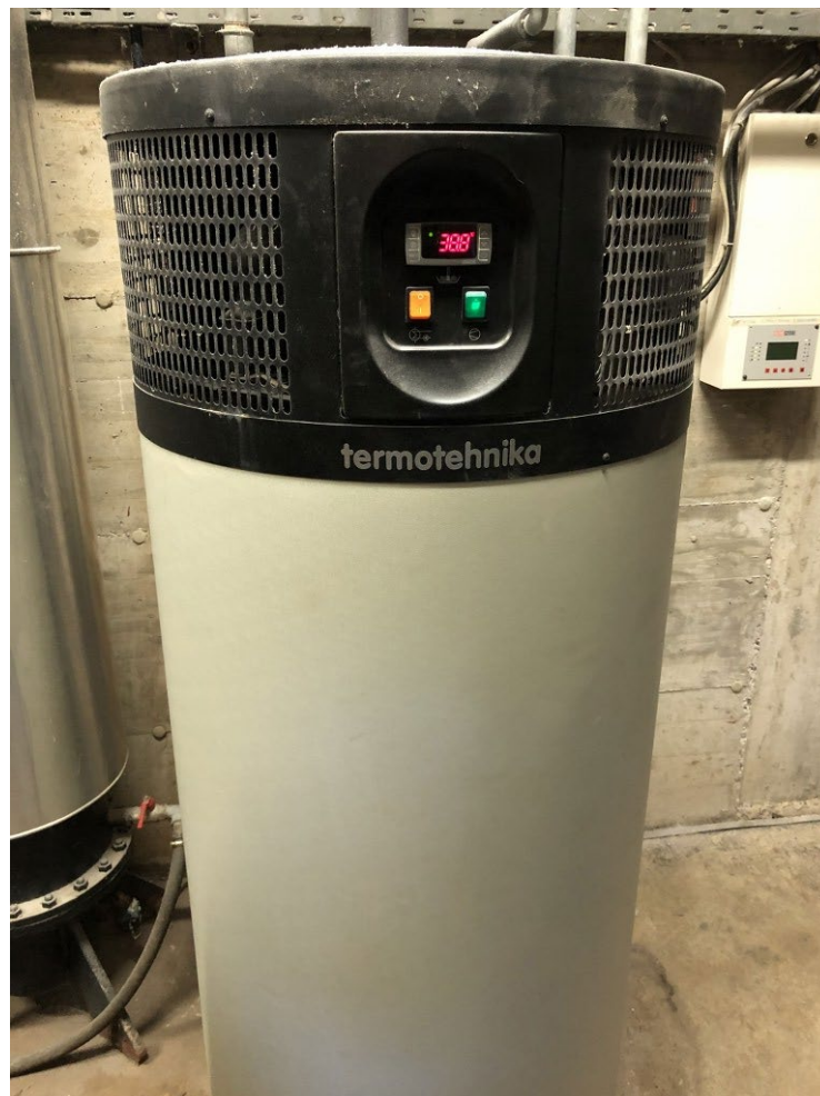
Slika 25 Toplotna črpalka za potrebe dogrevanja TSV
