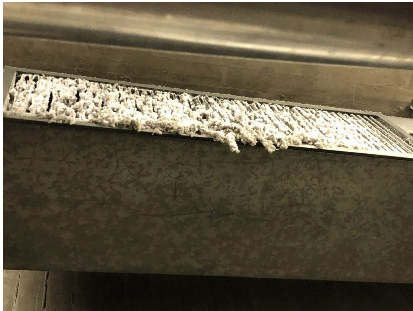
Slika 30 Neočiščen, zastarel sistem prezračevanja
