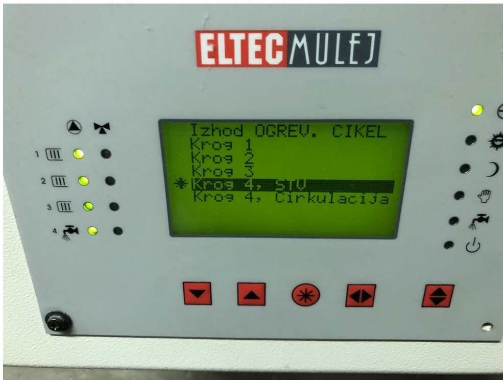
Slika 27: Nadzorni sistem ogrevanja ELTEC MULEJ
