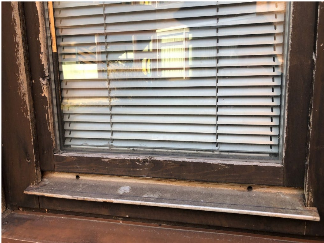
Slika 41: Dotrajana okna z več napakami
