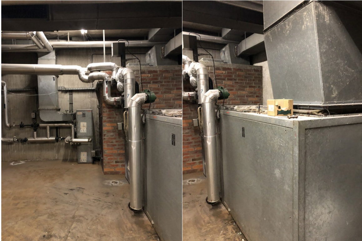
Slika 29 Zastarel sistem prezračevanje brez rekuperacije
