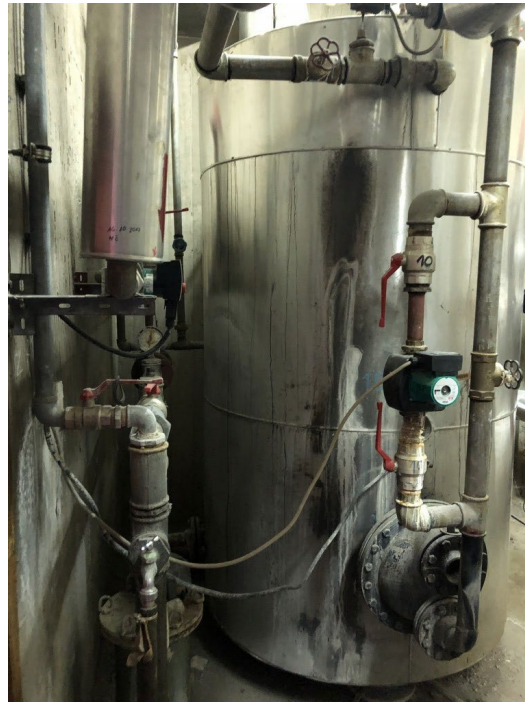
Slika 20: Slika zalagovnika tople sanitarne vode
