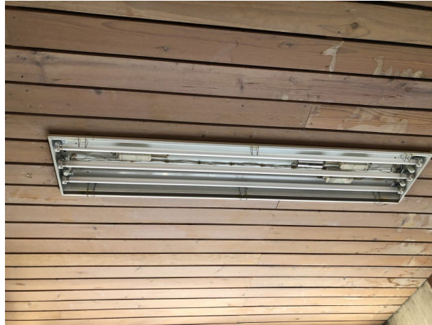
Slika 35: Primer cevastih sijalk v nadstropju brez pokrova
