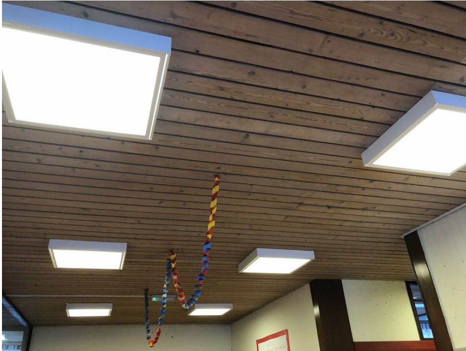
Slika 33: Primer LED svetilk na hodnikih
