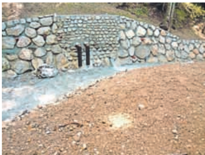
Novozgrajeno vodno zajetje na Smokuški planini
