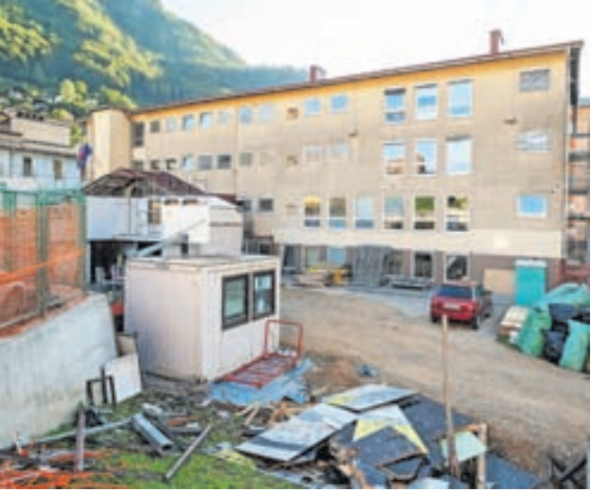
Gradnja telovadnice pri OŠ Poldeta Stražišarja / FOTO: NIK BERTONCEJ
