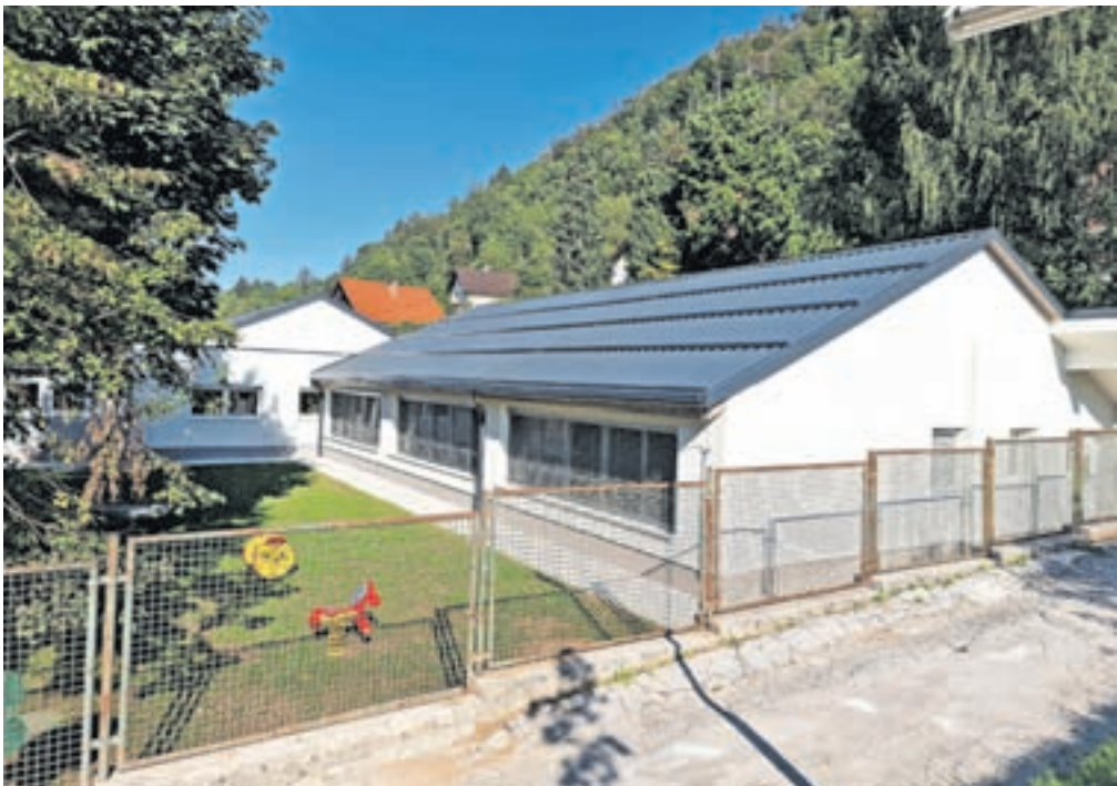
Zaključila se je energetska sanacija t. i. novega dela enote Julke Pibernik v Vrtcu Jesenice. Občina Jesenice se že pripravlja tudi na obnovo t. i. starega dela, s čimer bodo pridobili prostore za dodatne oddelke vrtca. / FOTO: OBČINA JESENICE
