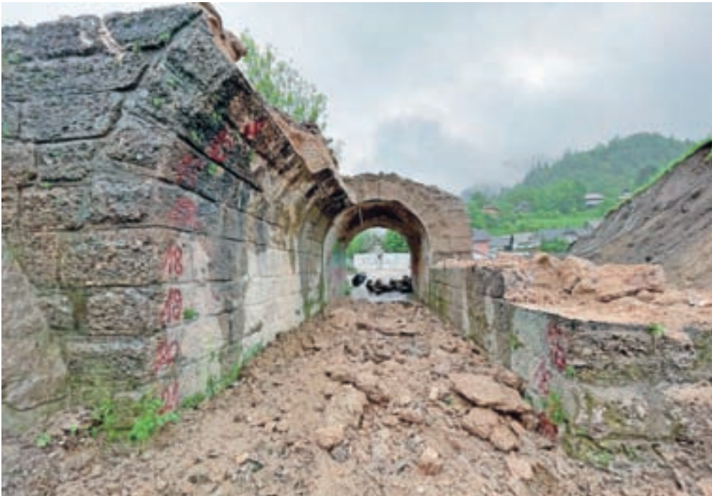
Razstavljanje kamnitih blokov / Foto: P. A.
