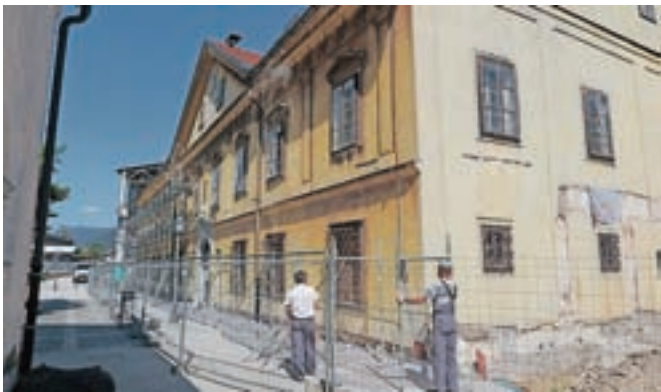
Ruardovo graščino bodo celovito prenovili.
