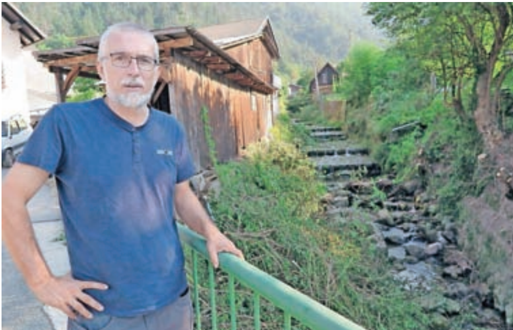
Aleš Klabus iz VGP Kranj je predstavil potek sanacije hudournika Bela na Koroški Beli.
